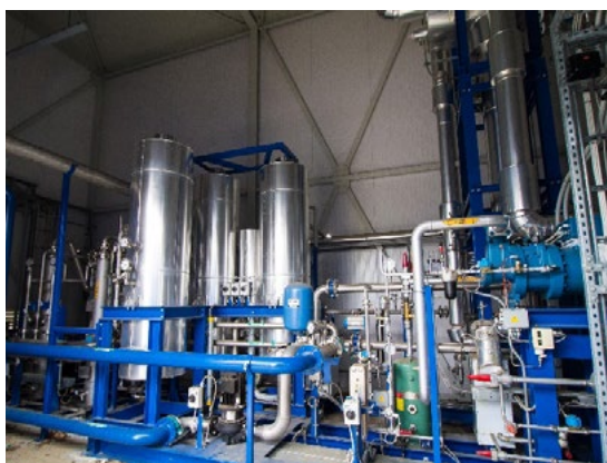
Het CO 2 -terugwinningssysteem
