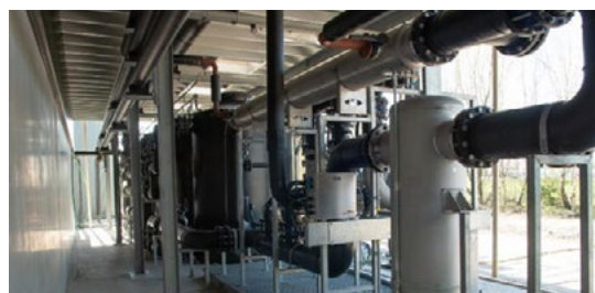
De biogasopwerkingsinstallatie
