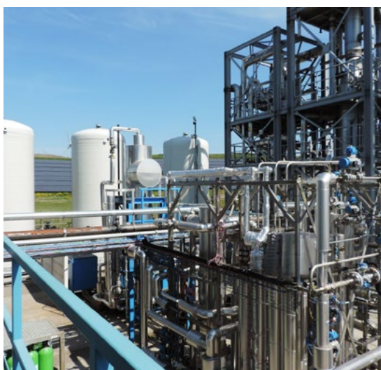
Opslagtanks feedstock en methanisatieskid
