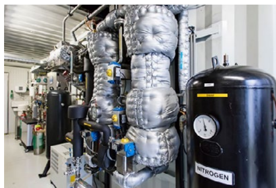
Binnenkant biogasopwerkingsinstallatie
