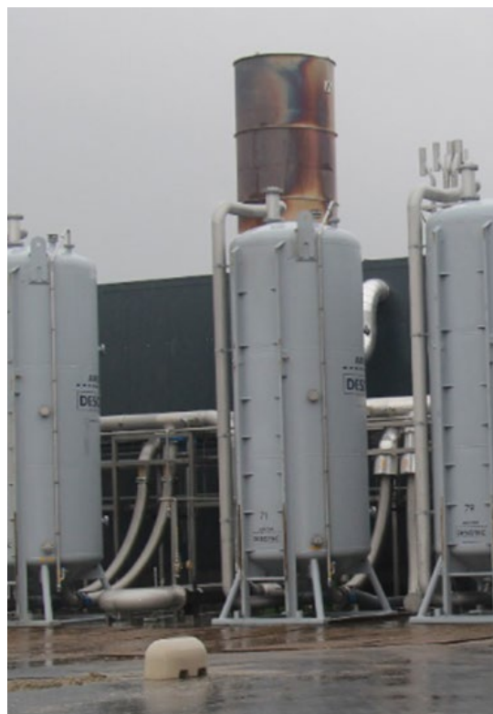
De biogasopwerkingsinstallatie
