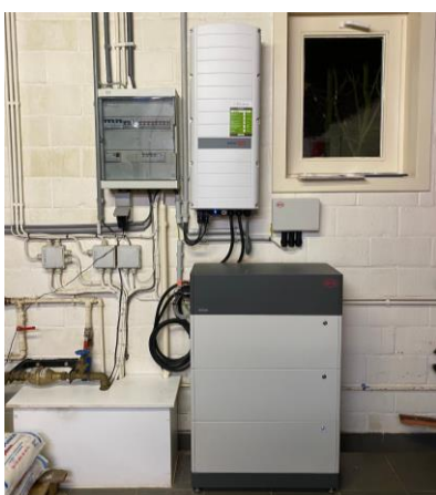
Figuur 3-5 voorbeeld accusysteem
