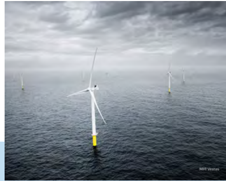
Luchterduinen windpark (Eneco)
