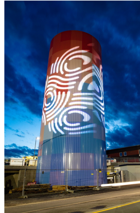
TTES in Detmold (Germany) – Stadtwerke Detmold, 1'850 m 3
